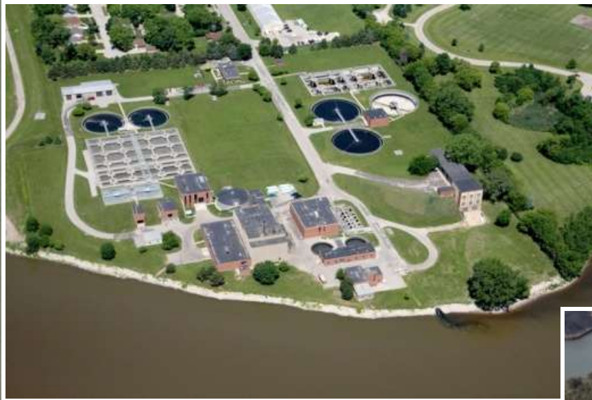
De Pere Facility
